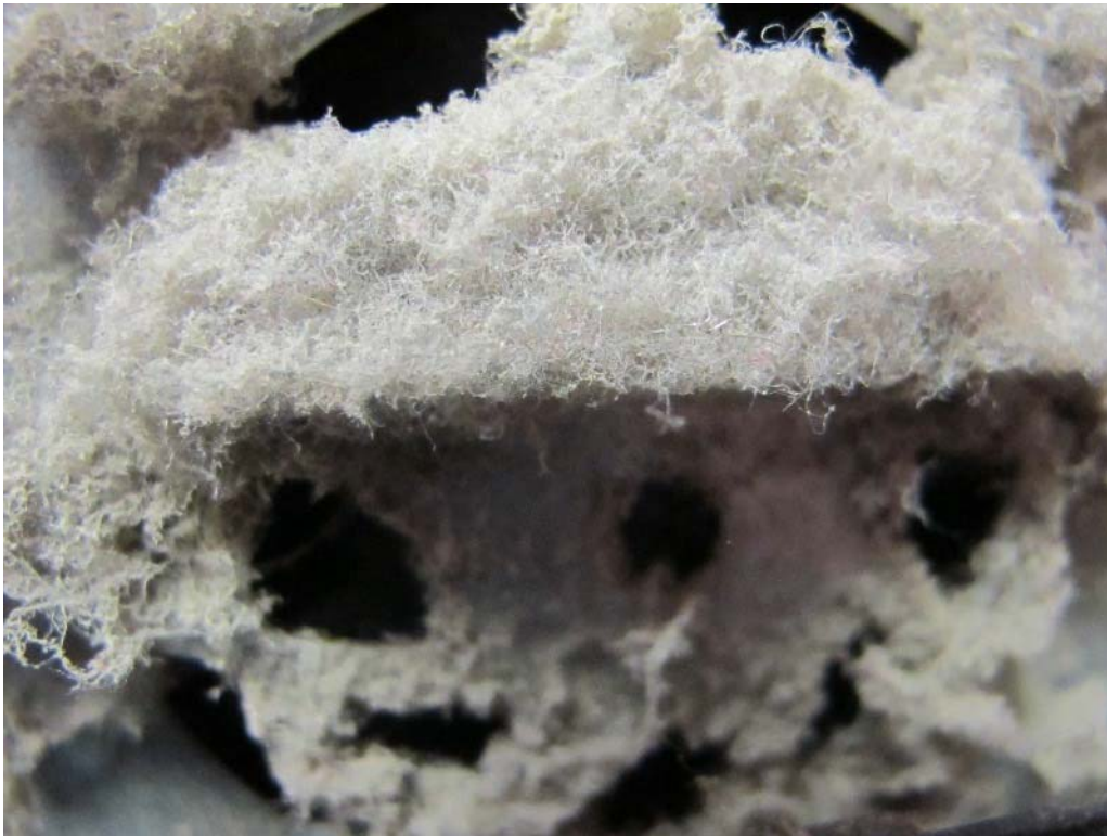
14 Achter het stof zit de ventilator om frisse lucht naar binnen te blazen.
